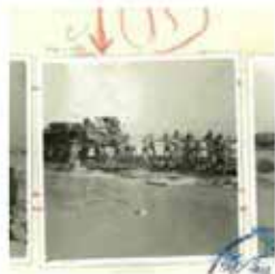
黄河橋梁架設作業状況 黄河上の機関車抱立
